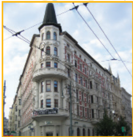
Gründerzeitbauten am Hasselbachplatz
