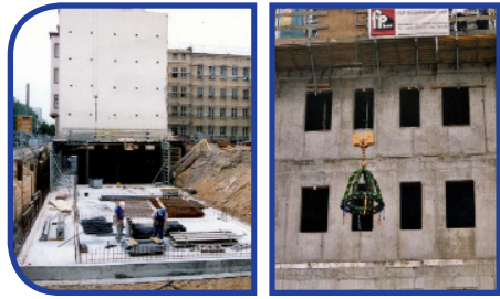
Baustelle des neuen Gebäudeteils und Richtfest, Oktober 2001
