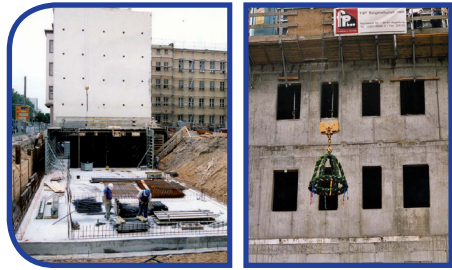
Baustelle des neuen Gebäudeteils und Richtfest, Oktober 2001
